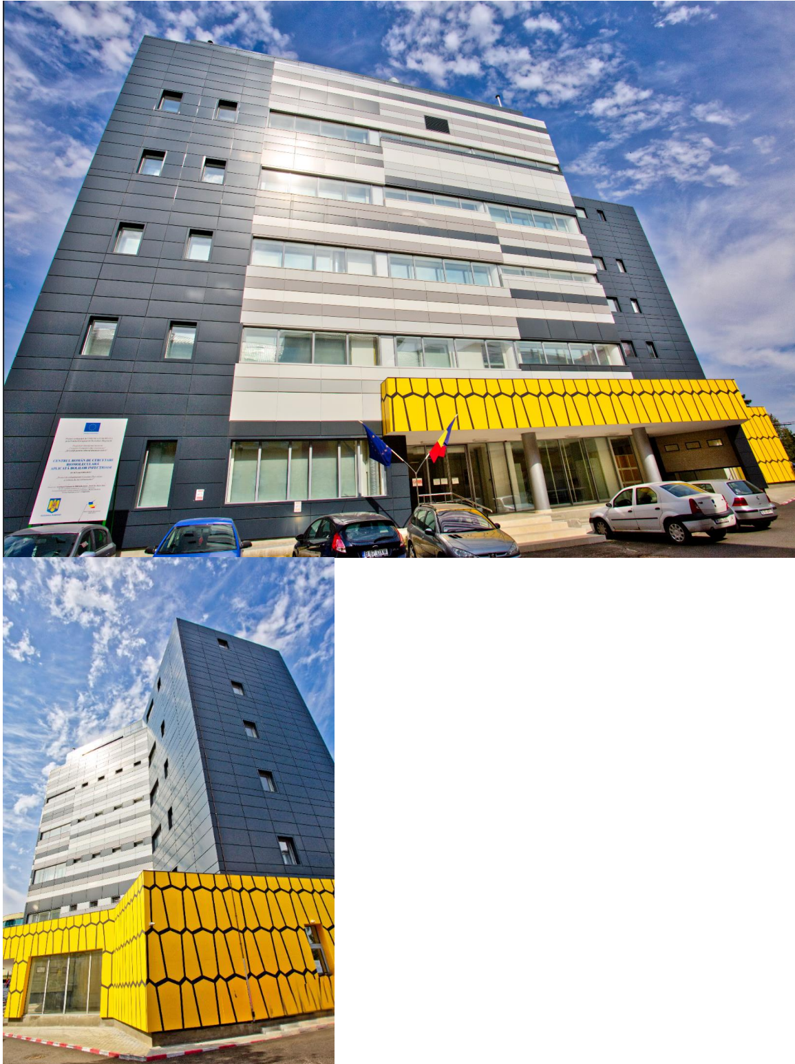
Clădire laboratoare în sistem de biosiguranță BSL III și IV
